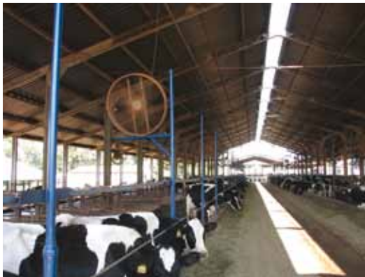
GALPÃO COM PRESENÇA DE LANTERNIM
