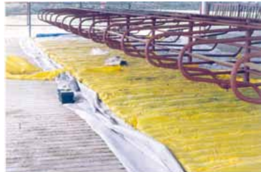
COLCHÕES SENDO COLOCADOS NO FREE-STALL. POSTERIORMENTE SERÃO REVESTIDOS COM LONA
