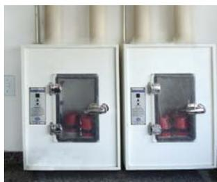
Sistema pneumático para transporte do sêmen até o laboratório
